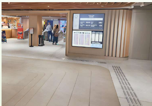
渡輪碼頭內的觸覺引路徑 Tactile guide path at pier
